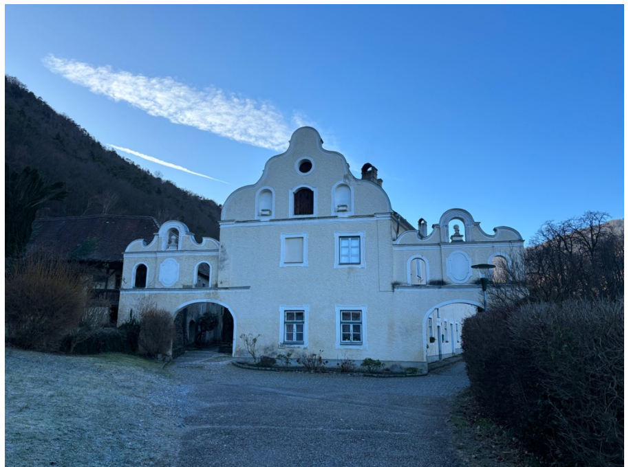
Abbildung 4: Wirtschaftsgebäude des Erlahof, Standort des AR04 (Foto - Jänner 2024), Lucas Nunzer
